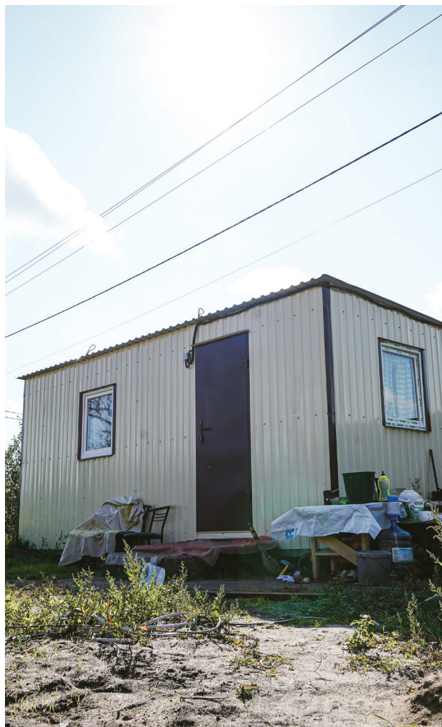
Dette er det nye midlertidige huset som Ungdom i Oppdrag har bygget for Nina. Huset er ikke stort, men det inneholder kombinert kjøkken og stue, bad og soverom. Her kan hun bo inntil noe mer permanent er på plass. Foto: Maria Olivie Huse
